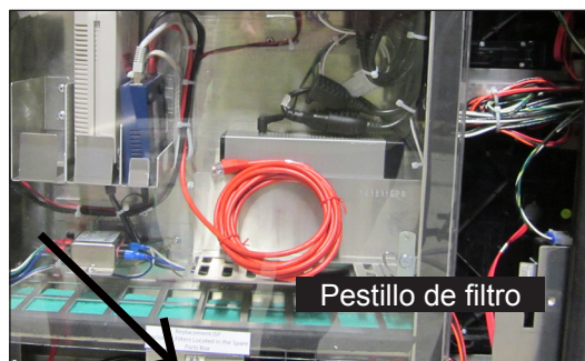
Figura 18: Pestaña de liberación del filtro de la unidad del ISP
